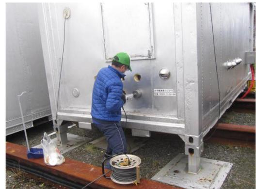
図4. コンテナ側面の鉄板にホールソーでΦ100mmの穴をあけているところ。屋外作業が多いので、風で体温を奪われないようにウインドブレーカー系の服を着用している。
